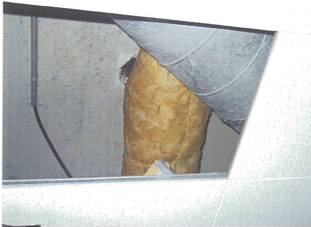
Composant : Calorifugeage laine de verre seule l'ensemble des calorifugeages de la zone de travaux
