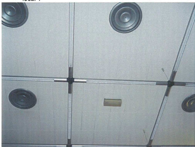
Composant : Faux plafond minéral idem prélèvement CAM4314/KT/08 locaux 4 et 5
