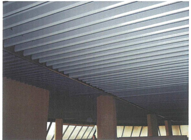
Composant : Faux plafond métallique l'ensemble des faux plafonds autre que minéral
