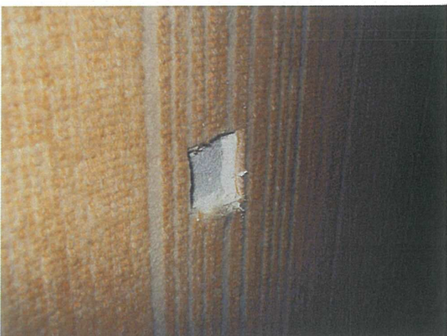
Composant : Enduits projetés enduit plâtre idem prélèvement CAM4314/KT/09 l'ensemble des enduits sur murs béton
